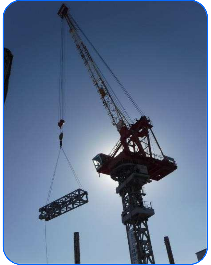
■タワークレーン
